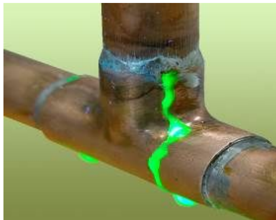
Регистрация утечки в системе охлаждения с помощью флуоресцентного концентрата
